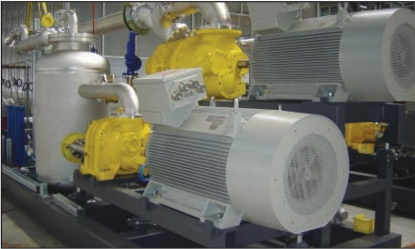
■ Dentro de un patín combustible, con dos compresores trabajando en serie para alcanzar la presión requerida por la turbina de gas cuando la presión que llega al lugar es muy baja.
