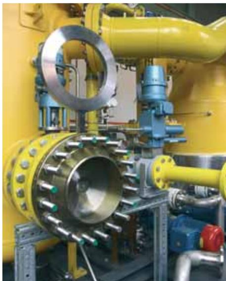
Imposante Komponenten der Baugruppe: Links der Filter zur Gasreinigung mit der grossvolumigen Ansaugleitung des Verdichters, in der Bildmitte der Ölabscheider und im Vordergrund die viel kleinere Druckleitung.
